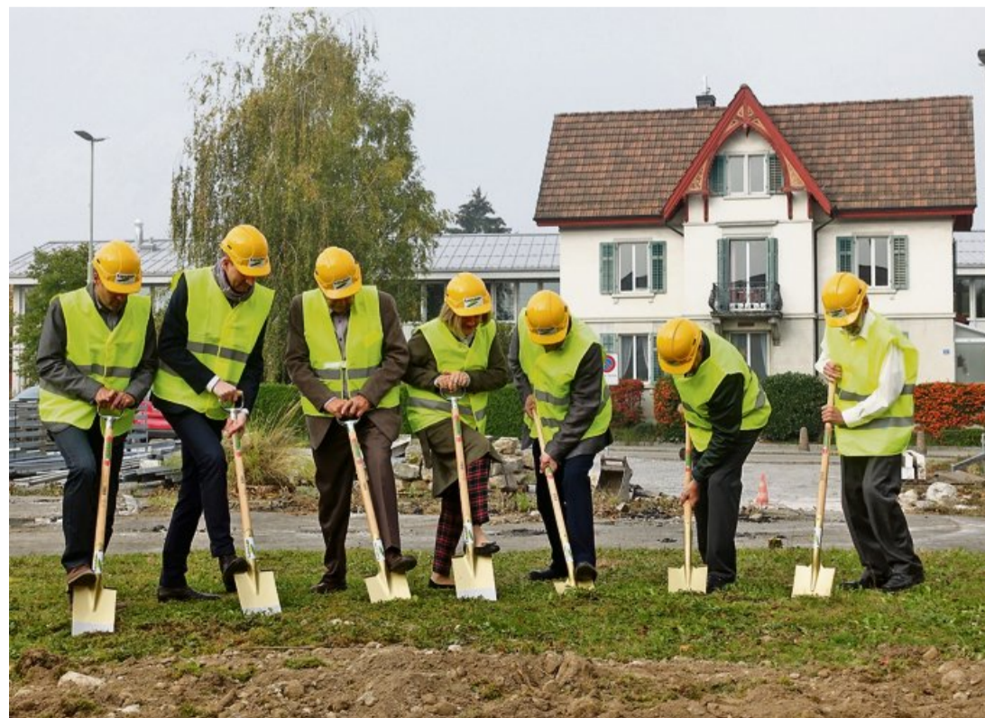
Der Spatenstich für den Neubau mit Alterswohnungen neben dem Alterszentrum Hofwiesen ist erfolgt. In zwei Jahren soll das Gebäude bezugsbereit sein. Foto: Daniel Grohé
